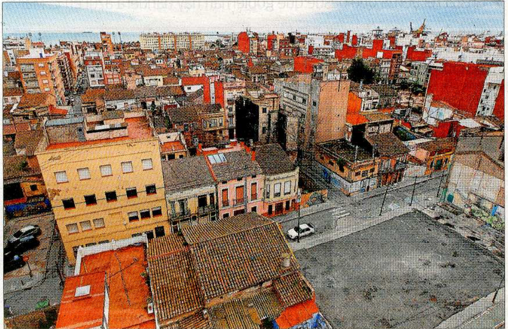
El Barrio del Cabanyal, que espera una rehabilitación desde hace años. EFE/JUAN CARLOS CÁRDENAS
