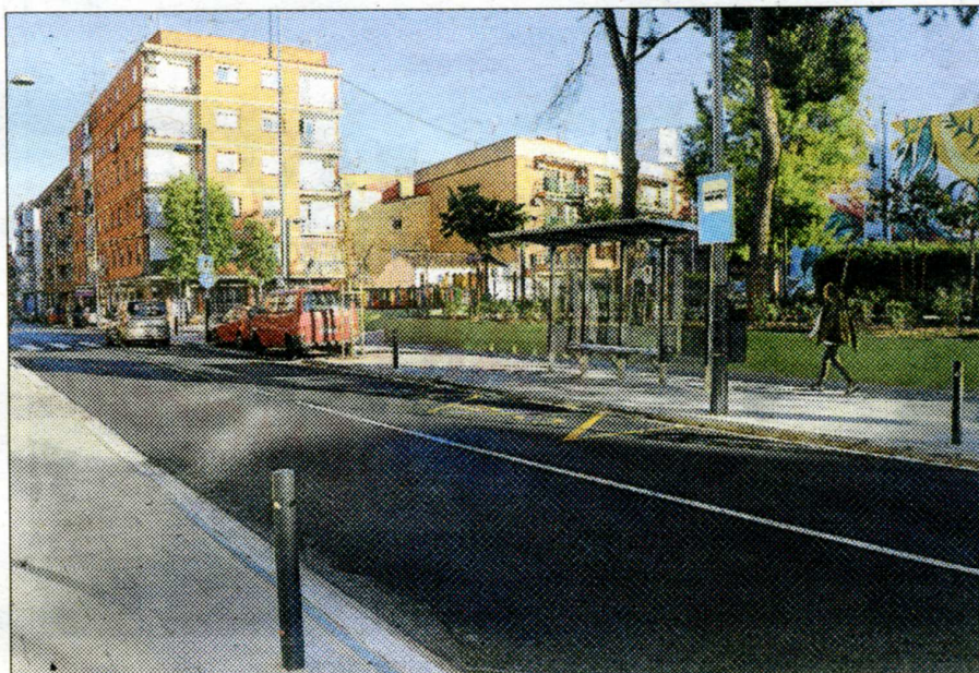
Obras en el Camí Reial, ya ejecutadas. A. T.
